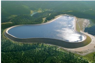
Die Energie von 1,775 TWh speichern wir im Oberbecken des Pumpspeichers (PSW) Goldisthal, der eine max. Leistung von 1060 MW und 12 Mio. m<sup>3</sup> Wasser für 8 Stunden hat. Damit ergibt sich die Anzahl der benötigten PSW-Goldisthal, um eine Tageserzeugung Strom zu speichern zu  $1,775 \text{ TWh} / (1060 \text{ MW} * 8 \text{ h}) = 1,775 * 10^{12} \text{ Wh} / (1,060 * 10^9 \text{ W} * 8 \text{ h}) = \mathbf{209 \text{ PSW}}$
